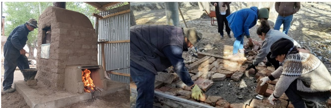
Figura 3. Construcción de horno de adobe alfarero en la escuela de Costa del Lepá Figure 3. Construction of a traditional adobe oven at the Costa del Lepá school
